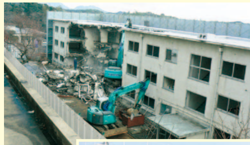
旧 1 号館の解体作業
